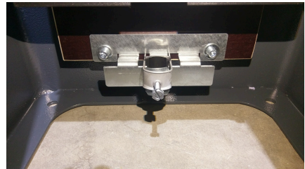
Abbildung 5.2: Beispiel für eine PUK-Zugentlastung
